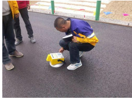
图 2 沥青压实度检测
