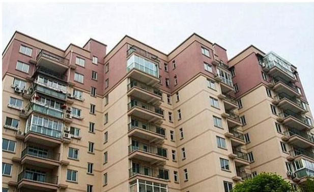
图1 高层住宅建筑
