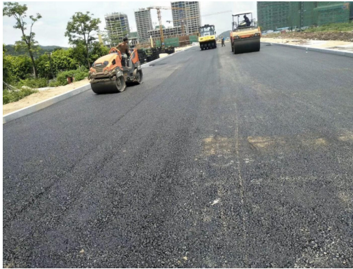
图 1 沥青混凝土路面施工现场
