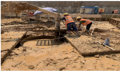
图2 气举反循环导管动态清孔
