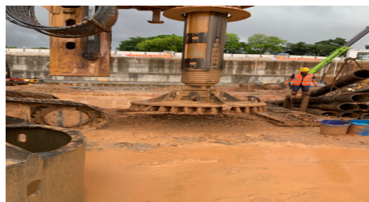
图 1 大直径桩清孔刷刷底
