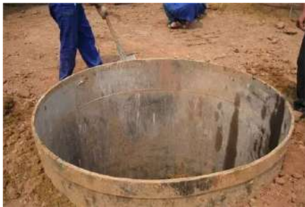
图 1 护筒施工现场图
