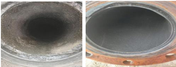
图6 输油管道涂膜后效果
