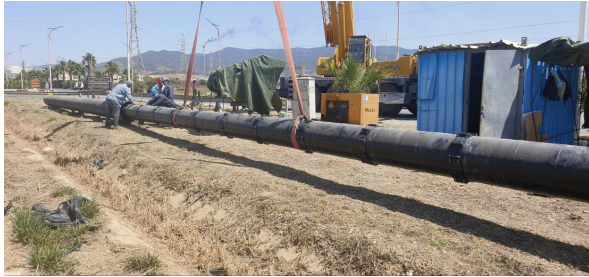
图2 内外套管安装
