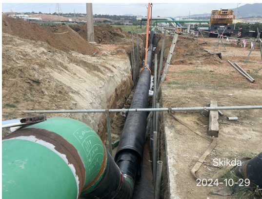
图3 埋地管道安装到位
