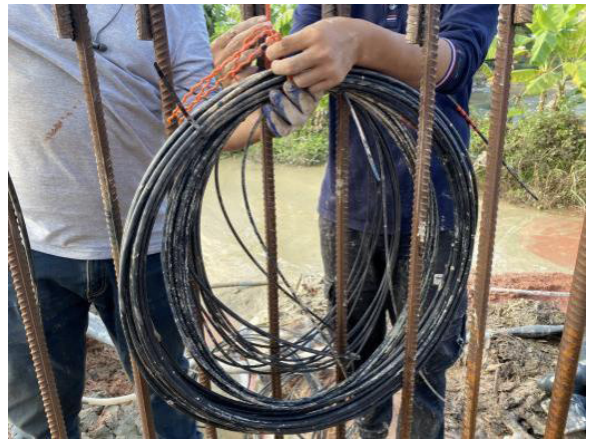
图 2 安装光纤的钢筋笼成品
