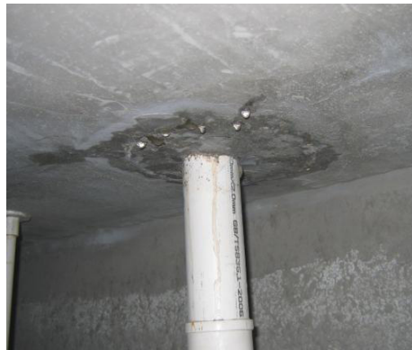
图1 卫生间渗漏示意图
