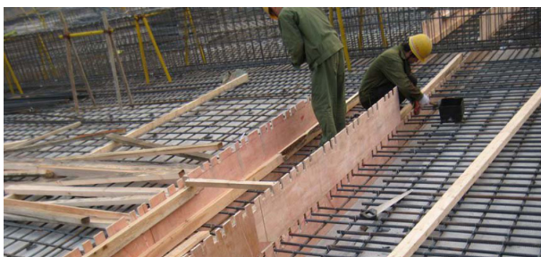
图1 后浇带施工现场实拍图
