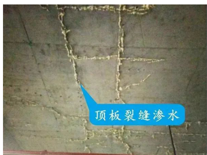
图2 地下室渗漏示意图
