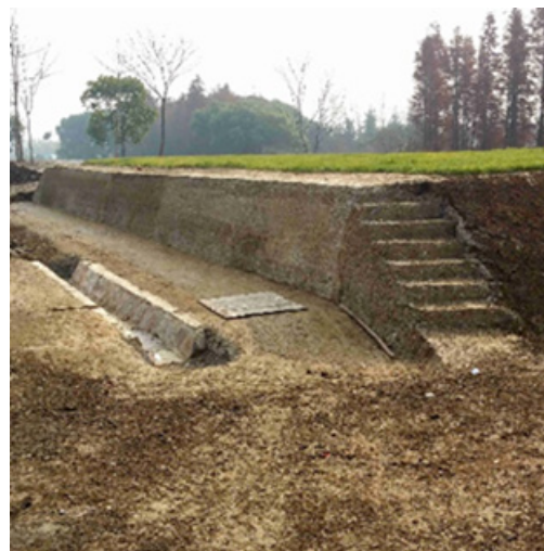
图3 阖闾城遗址保护施工
