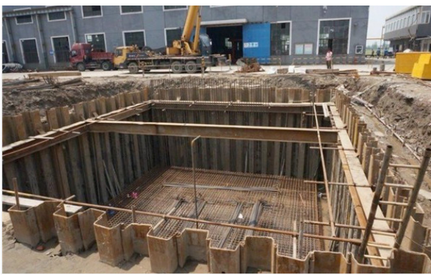
图1 地基基础施工
