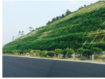
图1 高速公路边坡生态修复
