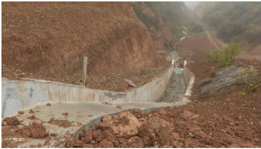
图2 农村地区水土流失严重
