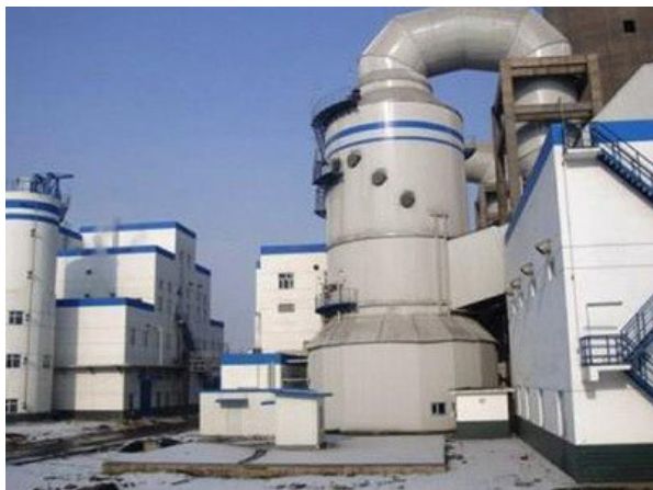
图1 火电厂脱硫系统
