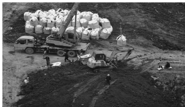
图1 采用换土法修复土壤污染
