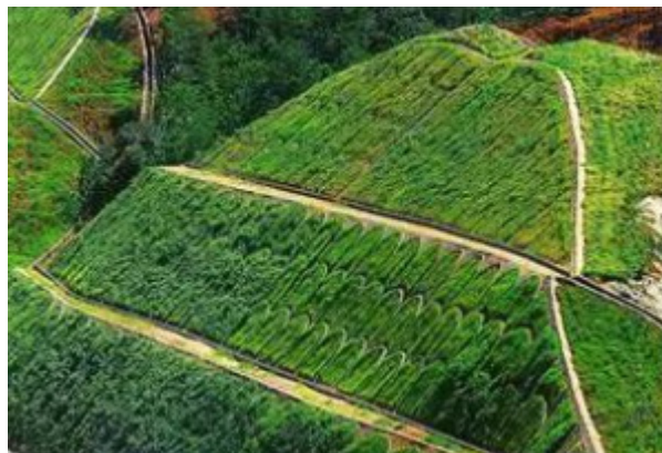
图2: 植被护坡工程
