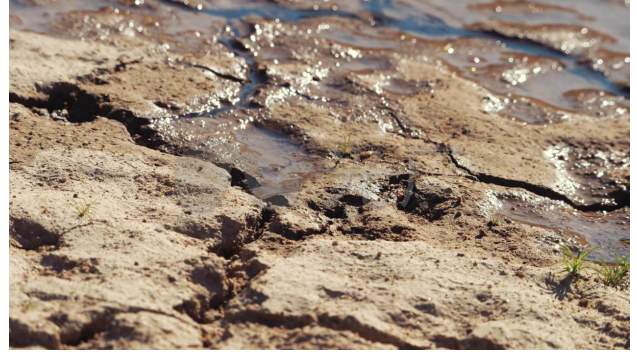
图2 湿涝交替引发的地表开裂图片
