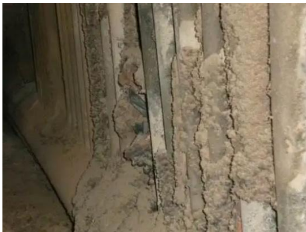
图2 锅炉结焦示意图
