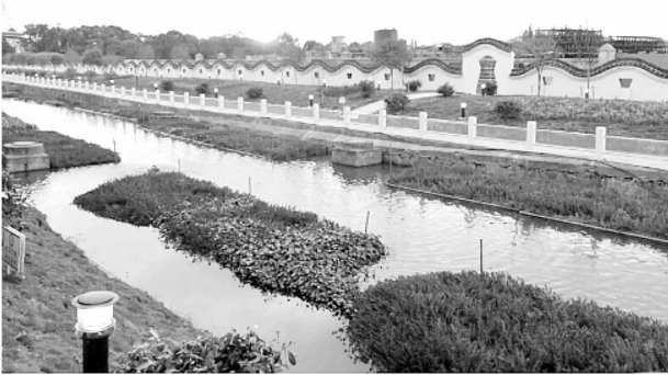
图1 河道水环境修复现状
