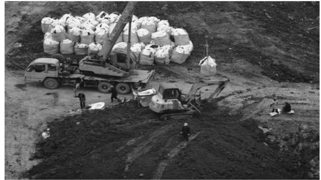
图1 采用换土法修复土壤污染
