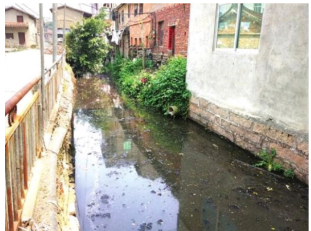
图 1 农村生活污水随意排放
