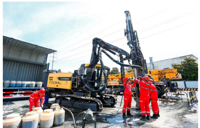
图2 应急演练——地铁隧道施工涌水涌砂应急实战
