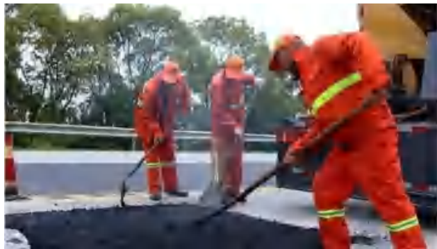
图1 公路养护路面坑槽修补
