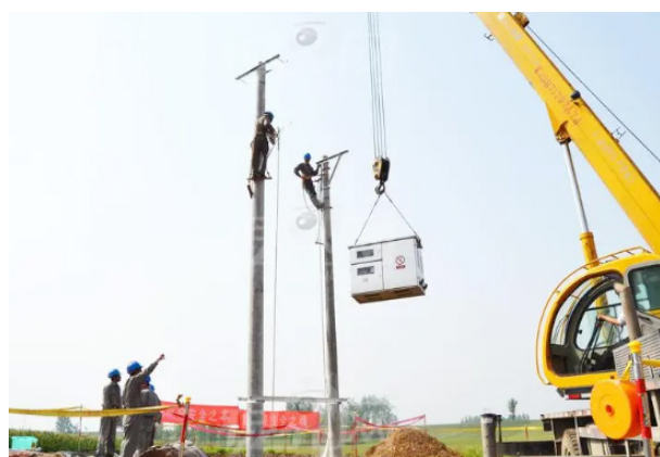
图2 电力工程施工现场
