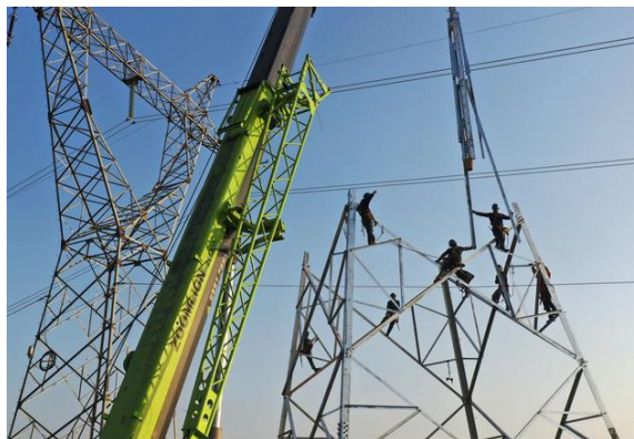
图1 电力工程施工作业
