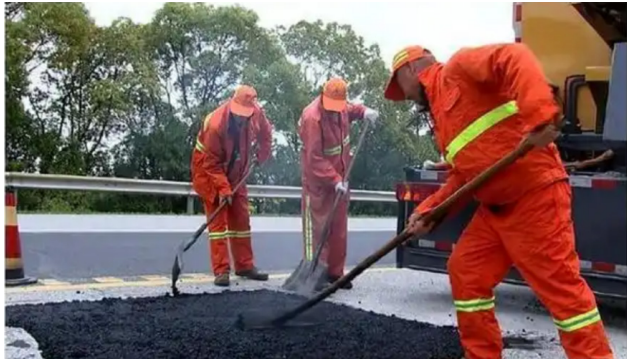
图1 公路养护路面坑槽修补
