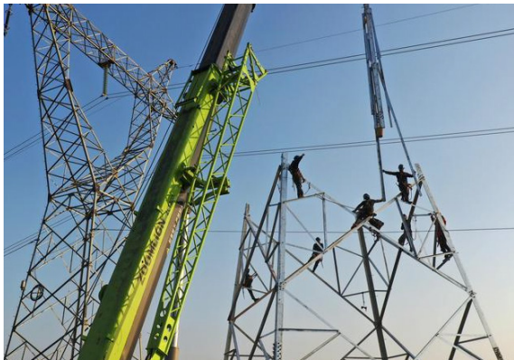
图 1 电力工程施工作业
