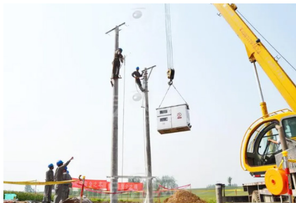
图 2 电力工程施工现场
