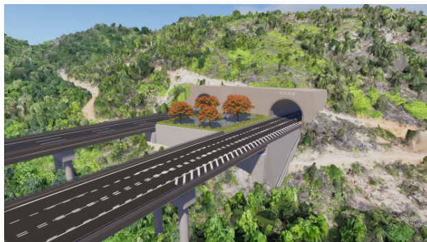
图3 桥隧结合倾斜摄影图
