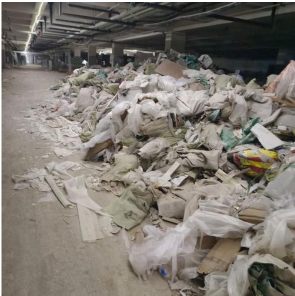
图 1 建筑固体废弃物
