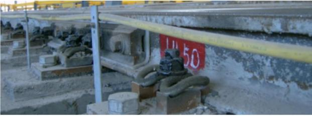
图 2 国内地铁某线交叉感应环线安装
