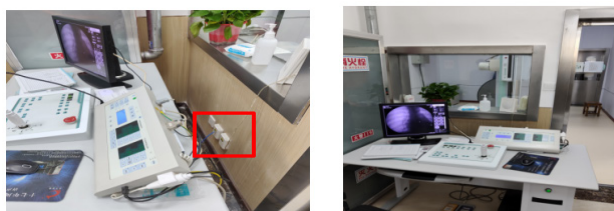
图3 诊室光网络面板安装效果图
