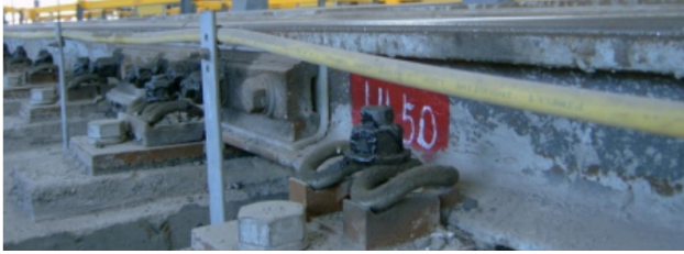
图 2 国内地铁某线交叉感应环线安装
