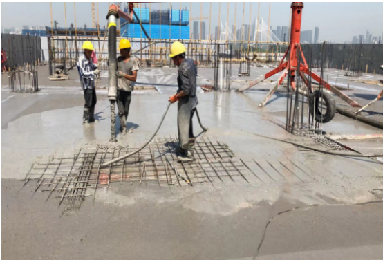
图 1 混凝土浇筑作业
