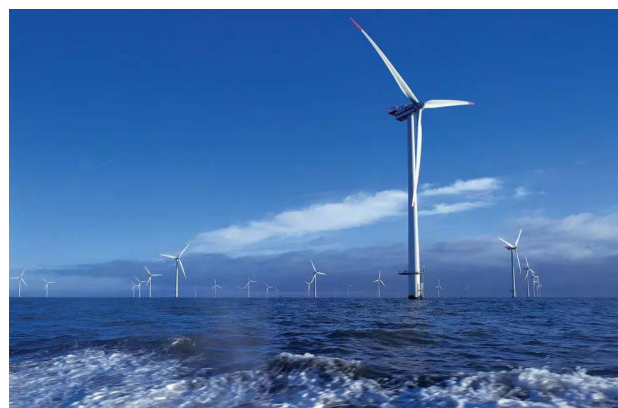
图 1 海上风电设施
