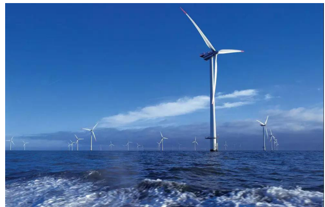
图 1 海上风电设施
