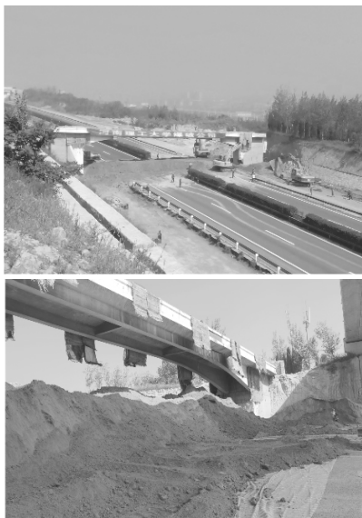
图1 高速公路路面防护措施
