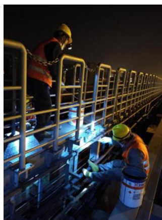
图2 疏散平台涂装维护中
