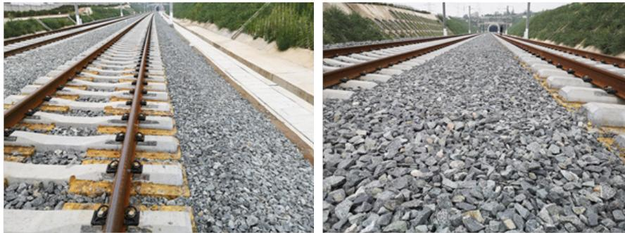
图5 装配式聚氨酯弹性道床成型
