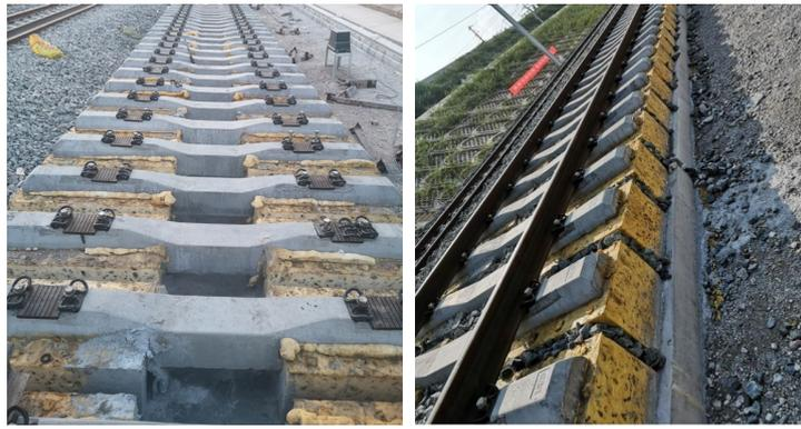
图4 装配式聚氨酯弹性道床过程
