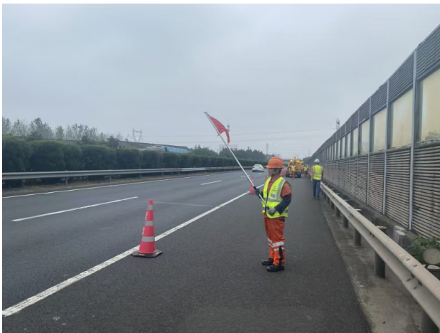
图2 道路养护作业
