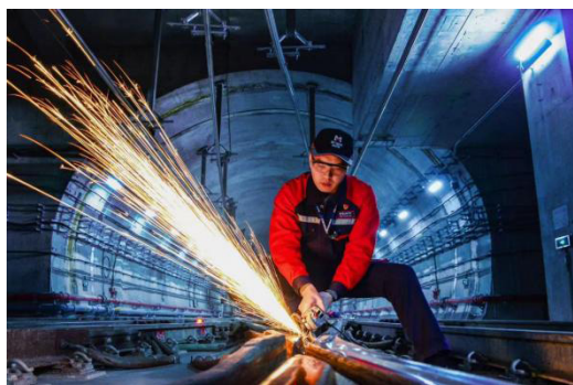
图1 地铁轨道线路养护维修现场图
