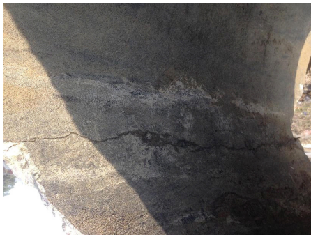
图 4 管内壁裂缝
