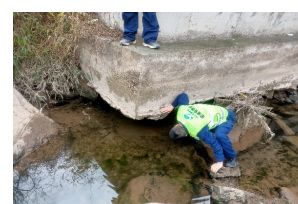
图3 承台底部局部冲空
