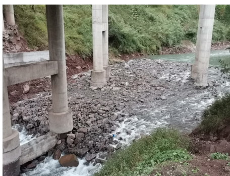
图11 水麻高速公路普洱渡立交桩基处治后
