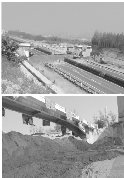
图1 高速公路路面防护措施
