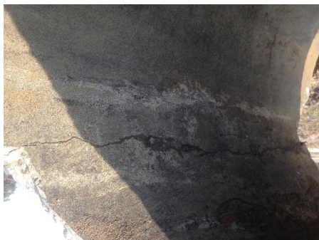
图4 管内壁裂缝
