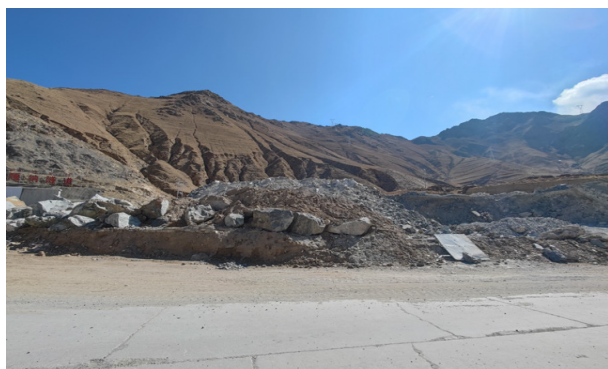
图1 某项目临时占有林地违法行为现场图(临时堆料点)
