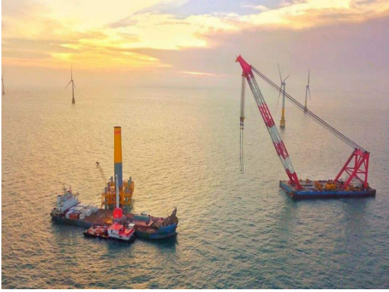
图1 施工阶段的海上风电工程
