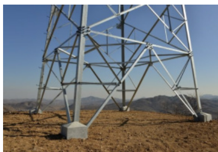
图 1 输变电塔基结构
