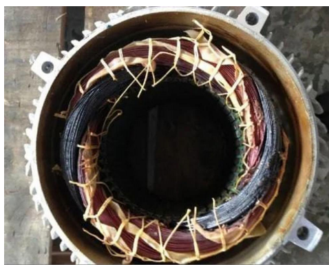
图1 变压器绕组故障示例图
