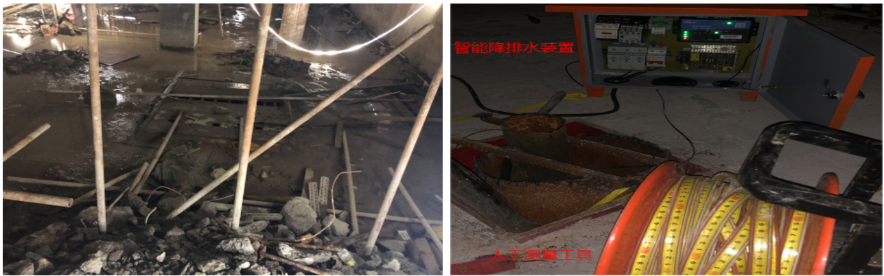
图 1 地下室监测点环境
