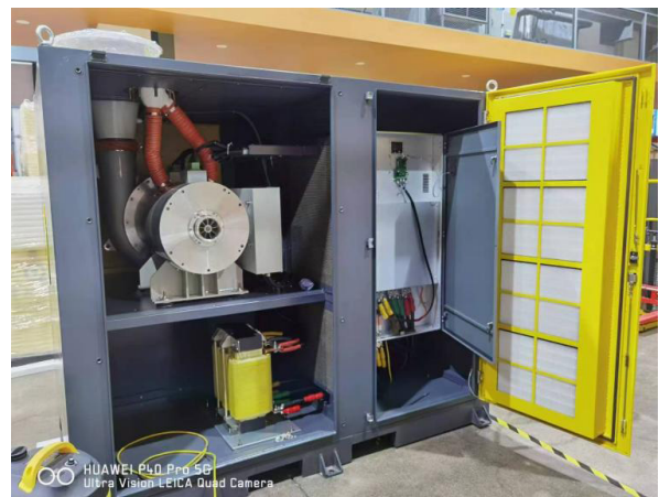
图2 燃煤火力发电机组脱硫化风机应用
