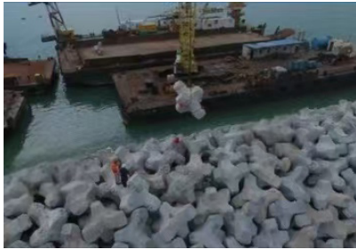
图 1 扭王字块吊装安放
